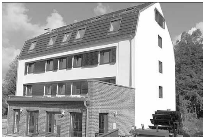
Blick von der Brücke auf das Maschinenhaus und die südliche Fassade des neuen Wohngebäudes.
