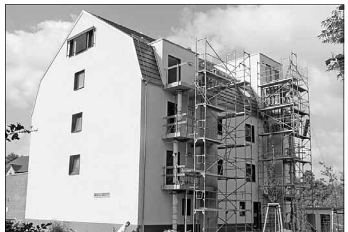
Anbau der Balkone an der Hofseite Mitte September.
