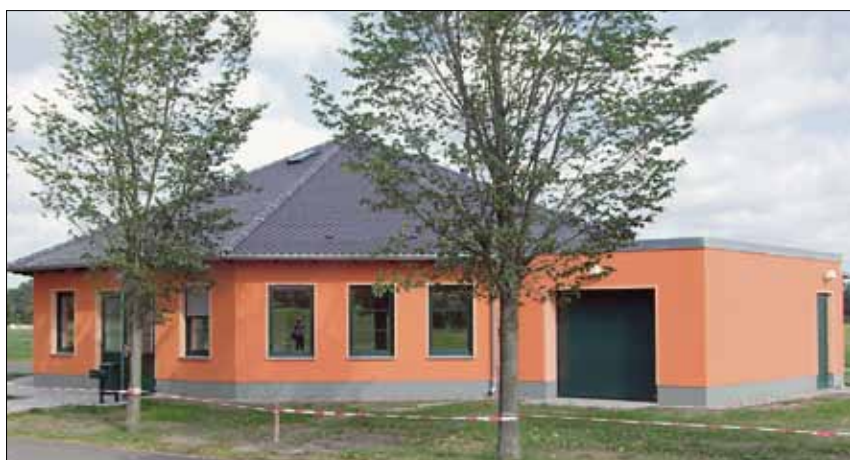
Das neue Sanitärgebäude am Sportplatz Neuendorf
