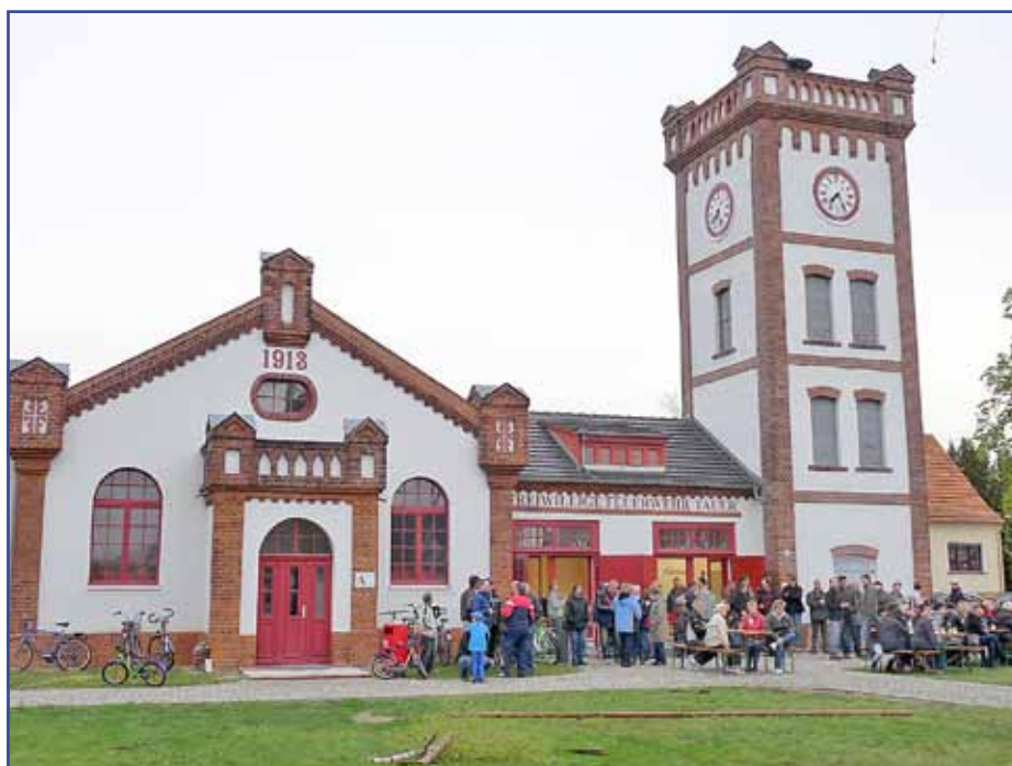
FF Gebäude Tauer
