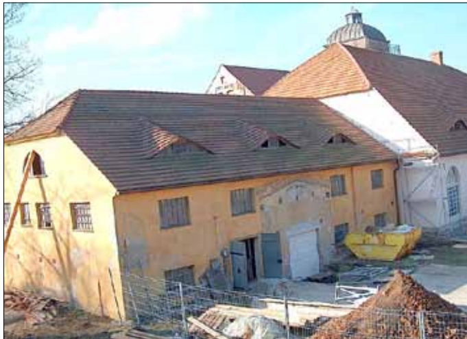
Die Bauarbeiten für das Fischereimuseum hatten begonnen. (Foto: Archiv Amt Peitz)
