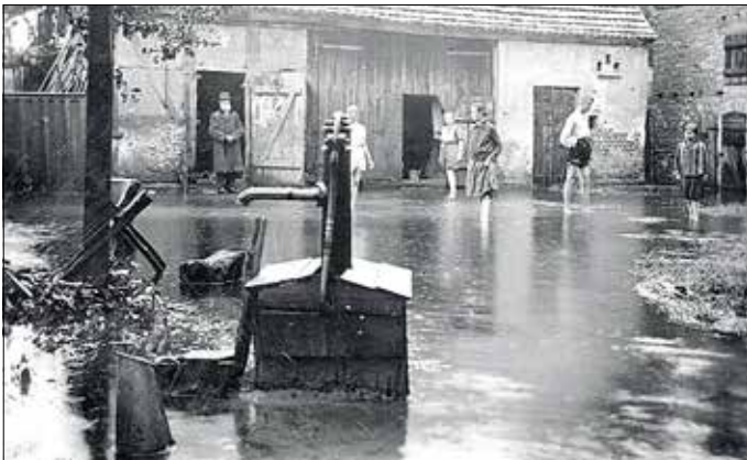
Wilhelm Findeisen (mit Gummistiefeln) nimmt zehn Tage nach dem großen Hochwasser von 1926 die Schäden auf dem Grundstück der Familie Paul und Martha Voigtmann auf.
