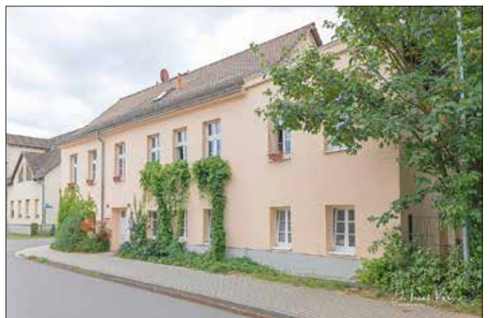
Hopfenranken an der Fassade der Dammzollstraße 39
