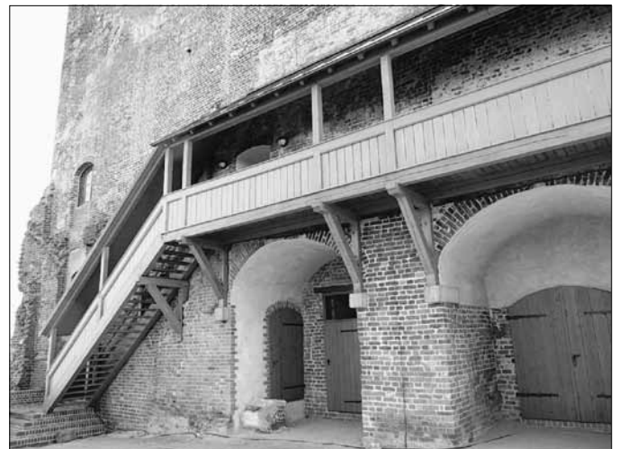
Der westliche Zugang zum Turm.
