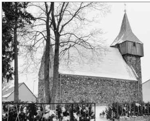
Die Wehrkirche Grieben im Winter. Sie wurde vor ca. 850 Jahren aus Feldsteinen erbaut.
