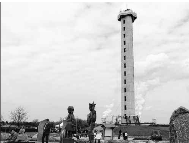
Mit dem 50 m hohen Turm hat der Götterhain einen imposanten Nachbarn bekommen. Viele nutzten die Chance, am Eröffnungswoche die 271 Stufen zu erklimmen und den einmaligen Blick auf die Region zu genießen.
