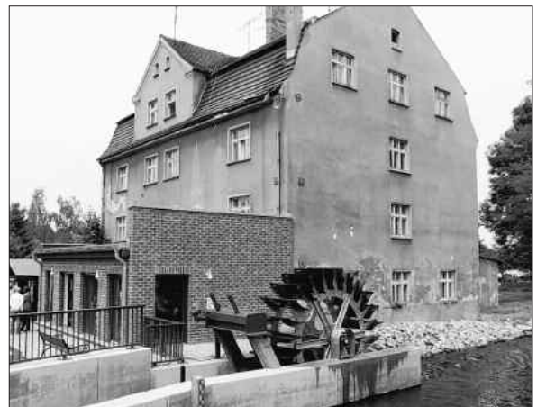
Blick auf das neue Wasserrad und das Maschinenhaus mit Museumsanbau. Das Gebäude selbst wird demnächst saniert und Wohnungen entstehen.
