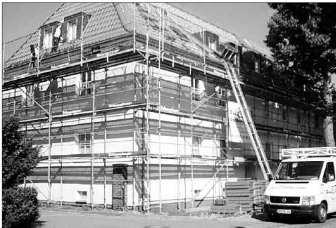
Sanierung Wohngebäude Dammzollstraße.
