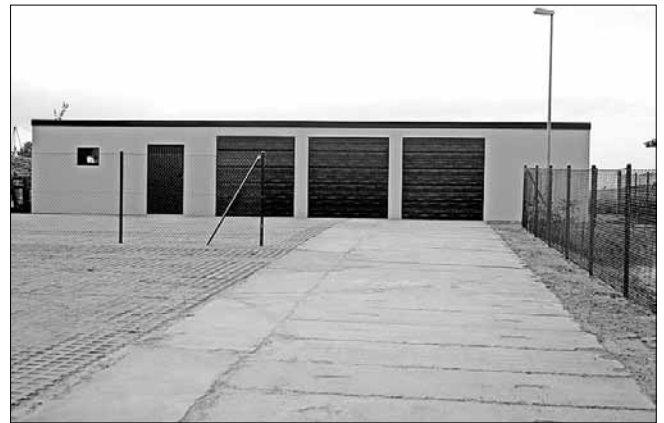
Der neue Technikstützpunkt
