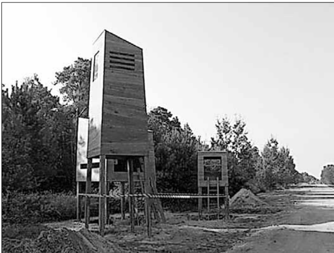
Blick auf die sich noch in der Fertigstellung befindende Seeachse, hier ein Bereich mit Kletter- und Aussichtselementen.
