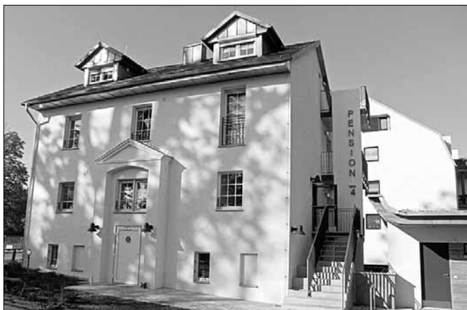
Die Pension mit dem neuen Eingangsbereich, den dahinterliegenden Balkonen und dem Anschluss an den eingeschossigen Anbau mit den Ferienzimmern.
