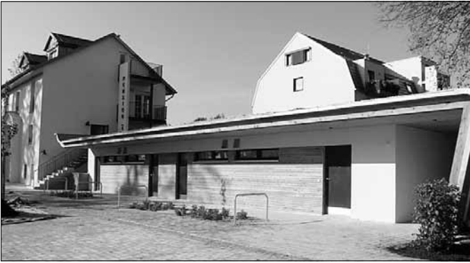
Pension Mühle 4 mit dem Anbau und rechts Bootsunterstellmöglichkeit.
