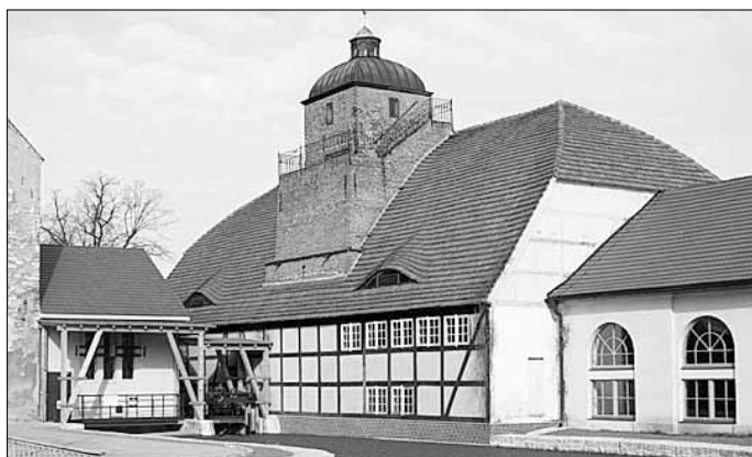
Oben links das alte Turbinenhaus 2011 und unten das sanierte Turbinenhaus und die neue Wehranlage mit dem Zufluss des Hammergrabens 2013 (kü)
