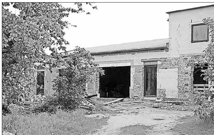
Umbau am Festungsweg 4
