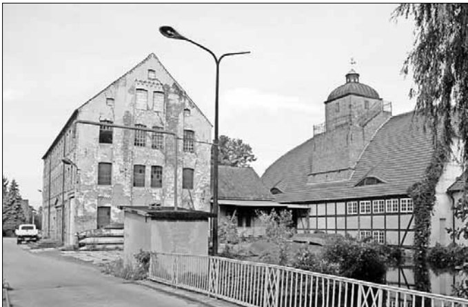
Das einstige Emailier- und Sauerstoffwerk mit deutlichen Spuren des baulichen Verfalls.
