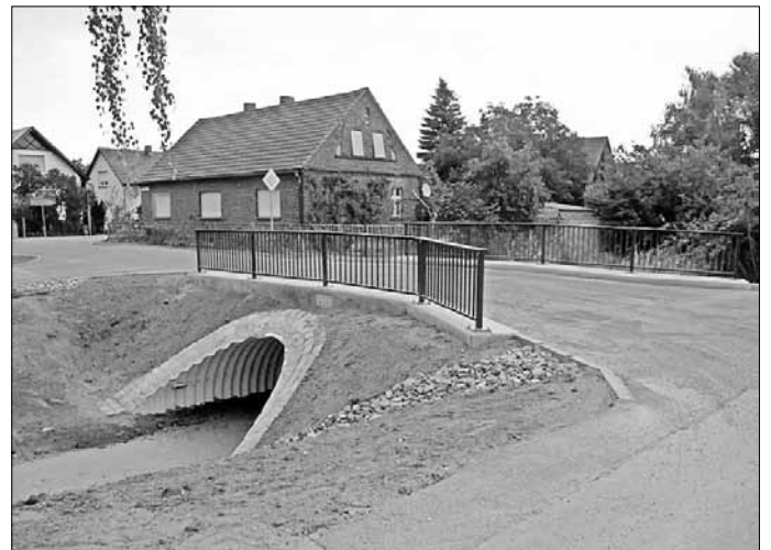
Die neue Wellstahlrohrbrücke über den Präsidentengraben am Friedhofsweg in Turnow
