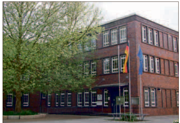
Verwaltungsgebäude des Amtes Peitz
