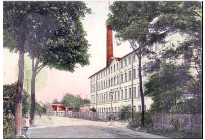
Die Trikot- Sammetfabrik Cottbuser Straße 2, nach Originaldruck Reinicke & Rubin, Magdeburg, um 1906
