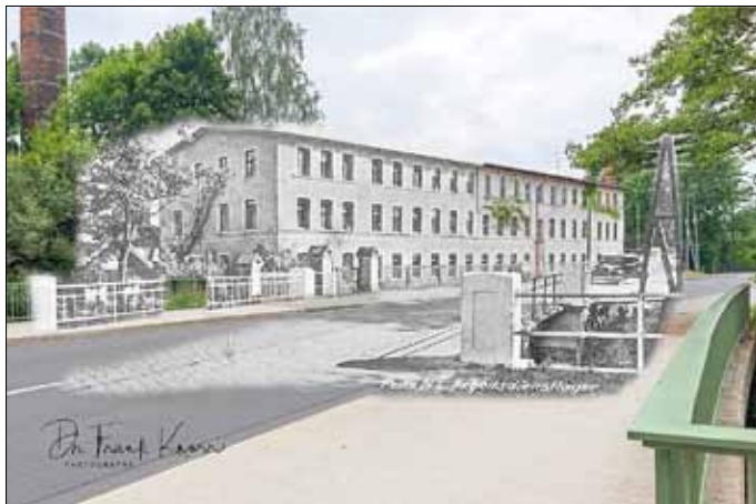
Bildmontage alt-neu des Arbeitsdienstlagers 1934 nach einer Postkarte der Verlage Reinhold Richter's Witwe, Peitz und Kurt Bellach, Guben, © Dr.-Ing. Frank Knorr, 2018
