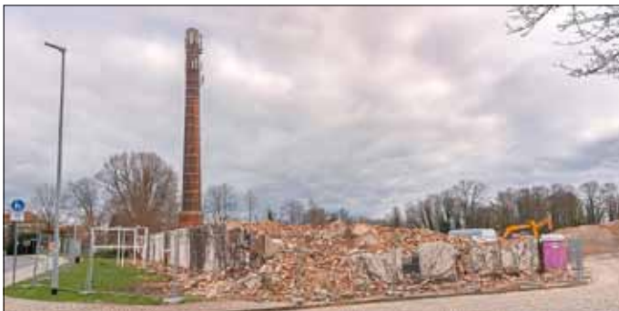
Abbildung 7: Abriss des ehemaligen Gebäudes an der Cottbuser Straße 3, Anfang 2019, © Dr.-Ing. Frank Knorr
