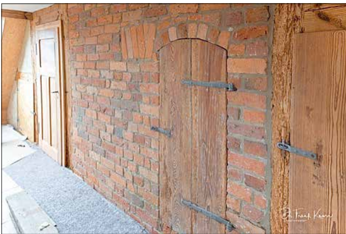
Eine liebevoll vom Putz befreite alte Ziegelwand aus dem frühen 18. Jahrhundert im Obergeschoss des Wohnhauses. Die Ziegel haben eine unterschiedliche Größe und Härte.
