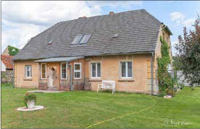
Das ehemalige Gutshaus, ein Ziegelbau, der später verputzt wurde ist die heutige Dammzollstraße 34. Der Vorbau wurde nach dem ersten Weltkrieg angesetzt. Die großen Dachfenster sind vor wenigen Jahren eingefügt worden und bringen Licht in den völlig dunklen Treppenaufgang.
