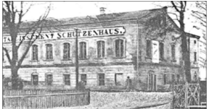
Das in massiver Bauweise errichtete Schützenhaus mit dem Saal im ersten Stock um 1880
