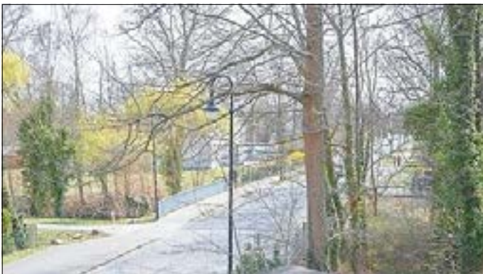
Aktueller Blick auf die Dammsollstraße mit der Malxebrücke, Copyright Dr.-Ing. Knorr, 2022
