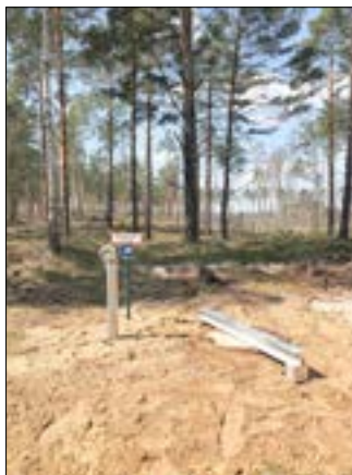
Fertigstellung Feuerlöschbrunnen im Wildnisgebiet Lieberose, Fotos: Stiftung Naturlandschaften Brandenburg
