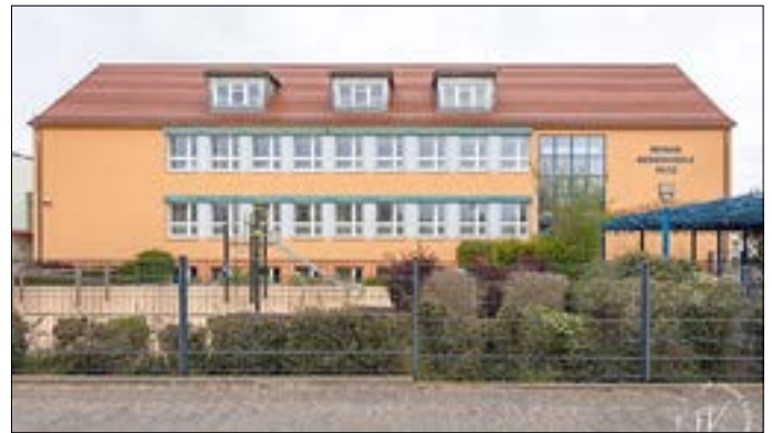
Abb. 30: Nebengebäude der Mosaik Grundschule
