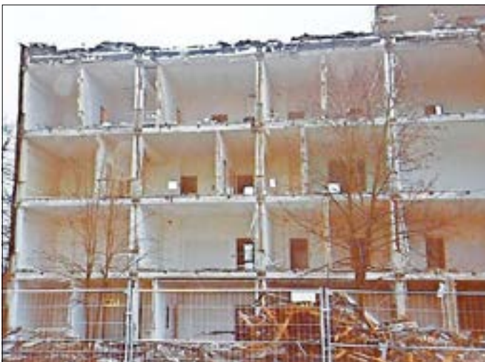
Abb.28: Abriss des einzigartigen ehemaligen Ambulatoriums, 01/2004
