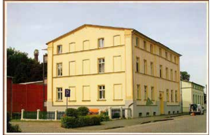
Abb. 14: Die denkmalschutzgerechte Sanierung der Dammzollstraße 68, Foto: Bauamt Peitz
