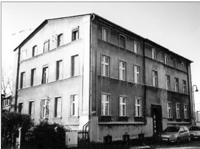
Abb. 13: Dammzollstraße 68 nach der Rückübertragung
