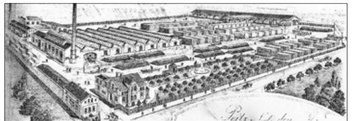
Abb. 4: Ansicht der Fabrikanlage mit dem Sheddach auf dem Holzbearbeitungsgebäude und den zwei Kesselhäusern im geschönten Briefkopf der DRAHT'schen Firma. Erkennbar sind auf dem Fabrikgelände verlegte Schienen, die aus der Schneidemühle zu den diversen Holzlagerplätzen führen. 1908.
