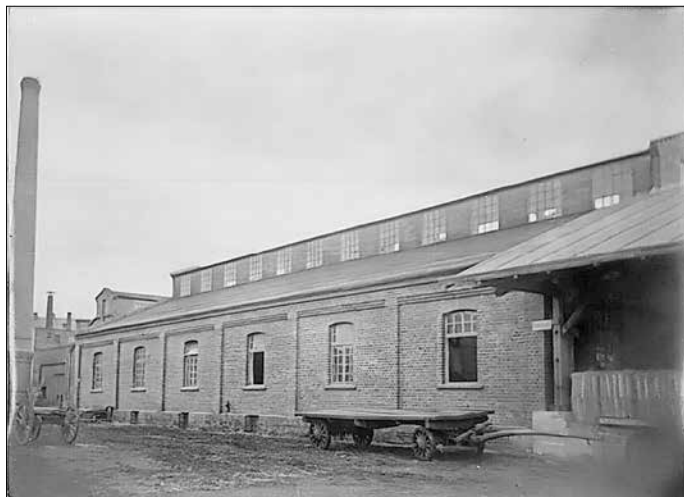
Abb. 10: Das neue Holzbearbeitungsgebäude mit der angebauten Bogenbinderhalle
