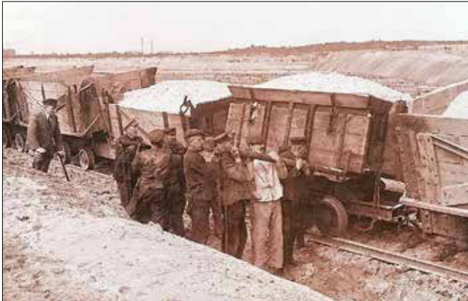
Abb. 11: „Knochenarbeit“ beim manuellen Kippen des Abraums mittels Kippbaum in der Grube Clara bei Welzow im Jahr 1927, © Kunstdruckmappe der LBV mbH um 1990, Sammlung Silke Butzlaff, Spremberg
