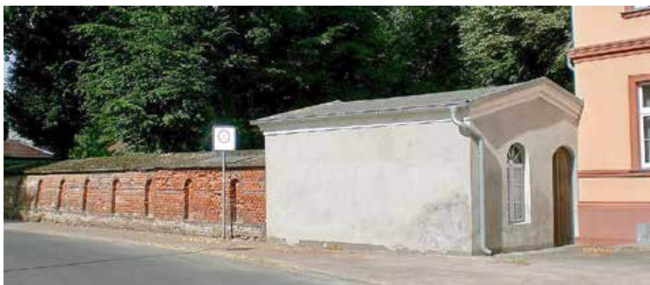
Die inzwischen eingestürzte Außenmauer der 1980 baupolizeilich gesperrten Kegelbahn aus dem Jahr 1833 und das 1871 auf zwei Drittel reduzierte Kegelhaus mit dem Eingang zum großen Garten am ehemaligen Hotel „Stadt Frankfurt“
