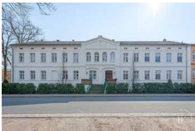
Abb. 2: Hauptgebäude der ehemaligen Tuchfabrik von Julius SCHULZE in der Dammzollstraße 52, erbaut vom Maurermeister DEUTSCHMANN (1847) und 2015 restauriert vom Bauingenieur WIEDEMANN, diente als Vorbild für die drei Tuchfabriken im Färbergrund
